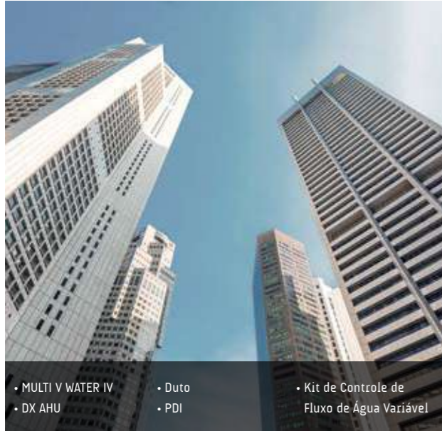
Edifícios de Grande Porte
