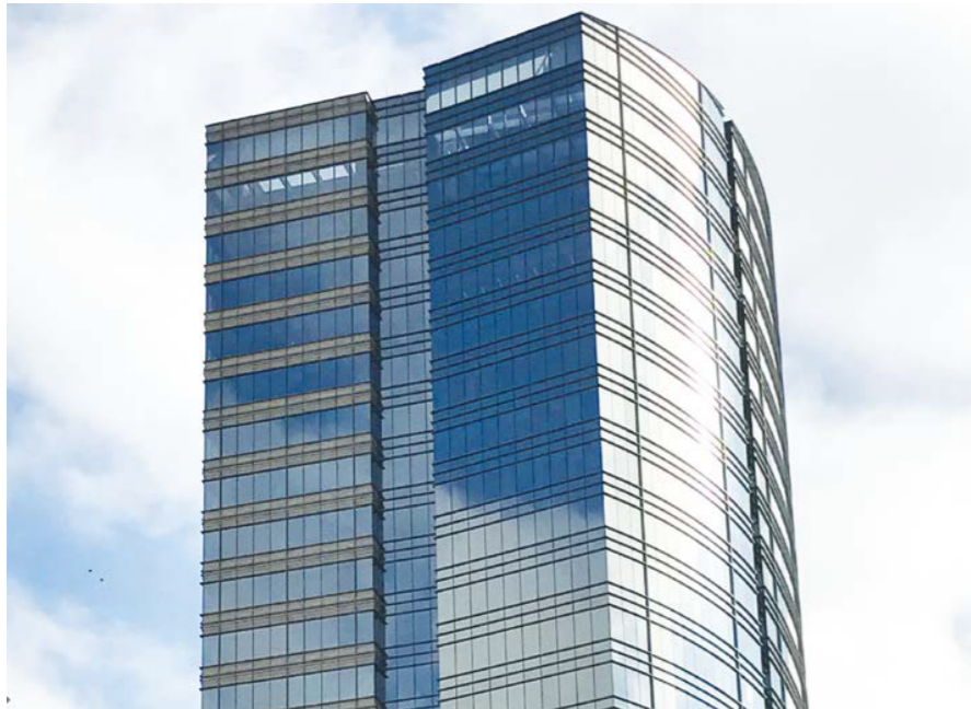
Edificio Torre Z
