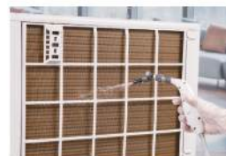
室外機清洗(不拆機) 54
